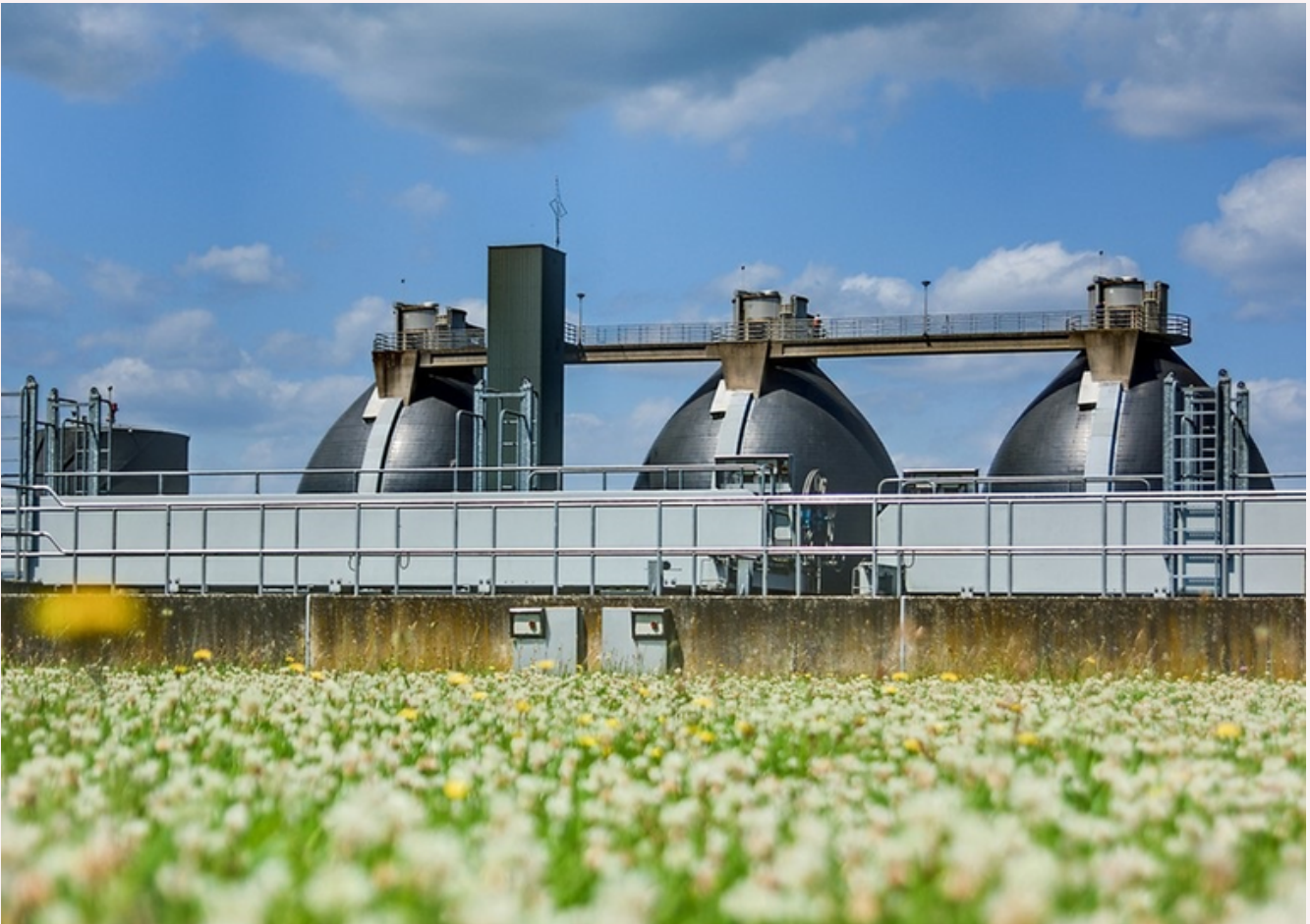
Waterzuivering en energiefabriek Hengelo
