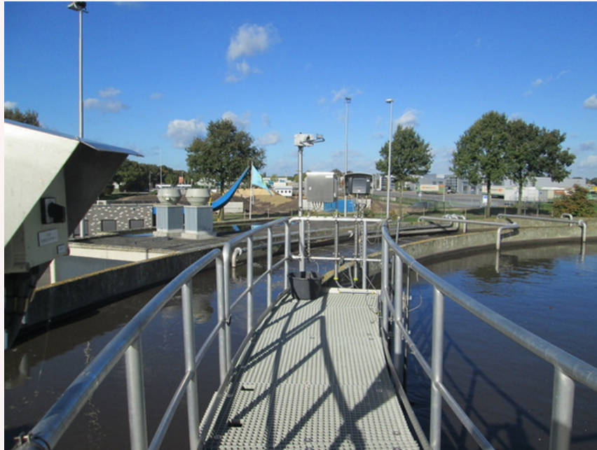
Rioolwaterzuivering in Dedemsvaart
