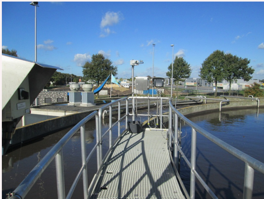
Rioolwaterzuivering in Dedemsvaart
